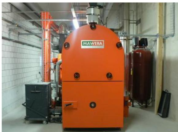
Abbildung 16: Heizkessel
